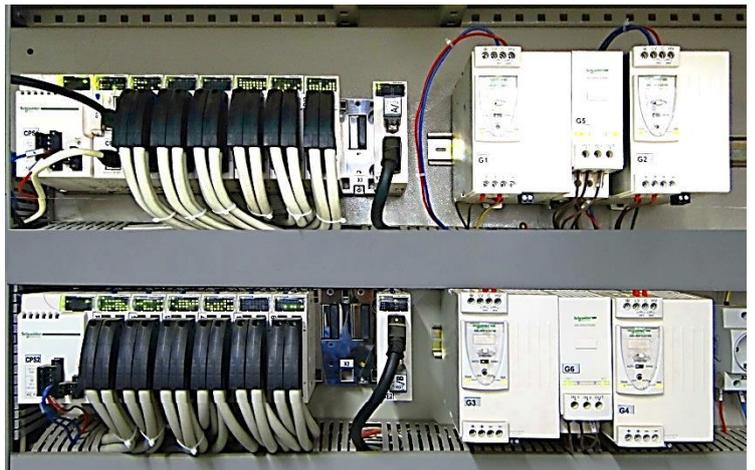
Для программирования ПЛК используется удобная функциональная среда программирования [SoMachine – Schneider Electric](#). ПО ПЛК использует типовые алгоритмические модули (функциональные блоки) для основных типов исполнительных устройств и характерных задач управления. Поэтому, при реализации объекта автоматизации, задача программиста сводится к адаптации программного обеспечения ПЛК к конкретному оборудованию объекта путем настройки уже имеющихся функциональных блоков.
